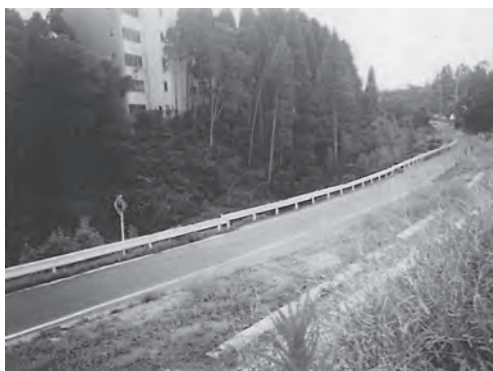
(左) 国際交流のみち整備事業着工前
